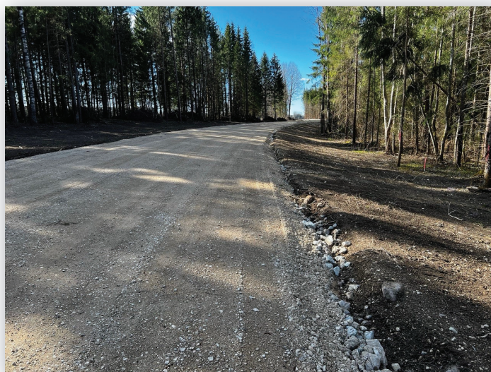
Läpi-Ojaküla tee. Sõida või ise! Kaitseväge rasketehnikaga igatahes saab. Teekonstruksioonis on kasutatud rehviplokke.
